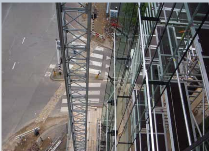
Tijdens aanbrengen van glasplaten
