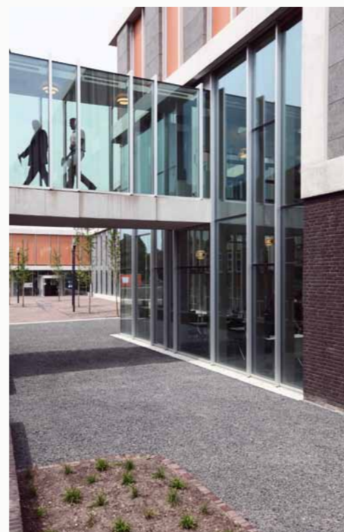
Van de nieuwbouw naar de oudbouw loopt een brug
