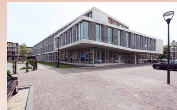
Gevels hebben aan de achterzijde veel meer natuurstenen penanten. Als privacy bescherming van de woningen?
