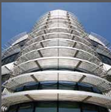
SUNCLIPS® ; structurele zonwering met vaste C-vormige lamellen
