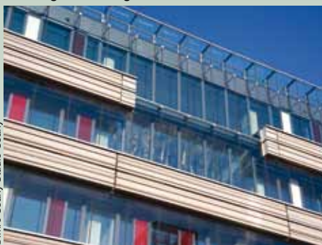
Geveldetail van een plek waar een 'hap' uit het gebouw is genomen
