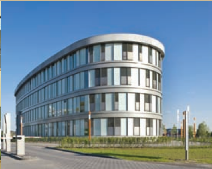
Buiten domineert het aluminium als koven rond de zonwering en als afdeklijsten op de houten vliesgevels
