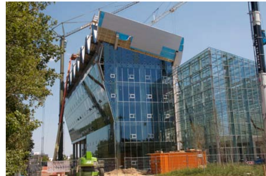
Villa Flora – Floriade 2012, Venlo – Architecten- en ingenieursbureau Kristinsson, Deventer. Het gebouw 'oogst' energie uit een kasconstructie.
