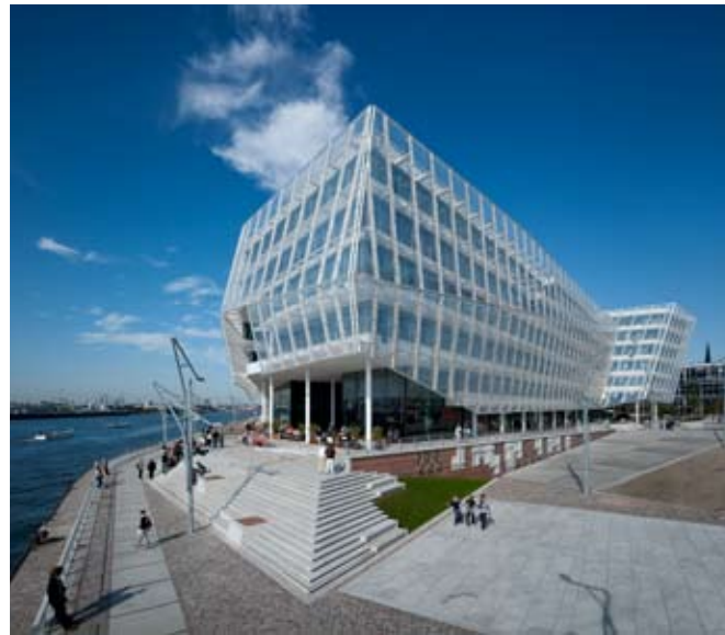
Unilever-haus, Hamburg - Behnisch Architekten, Stuttgart. Tweede huid gevel met EFTE-folie. (foto: Adam Mørk)
