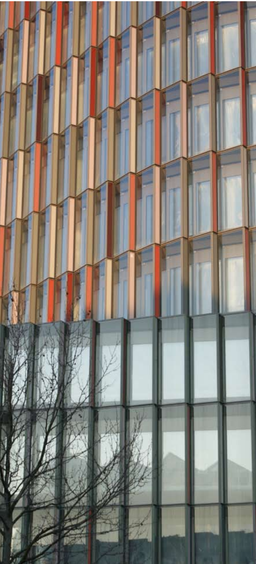
KfW building, Frankfurt - Sauerbruch Hutton, Berlin. Natuurlijke ventilatie, waardoor energiezuinig, het aanzicht verandert met het weer en het seizoen.
