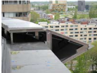
Plaatwerkvin (tijdens de bouw)
