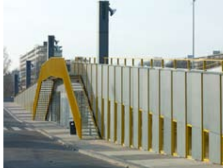
Gevel langs de toegangsweg: grijze vezelcementplaten en ramen met geel gecoate kozijnen
