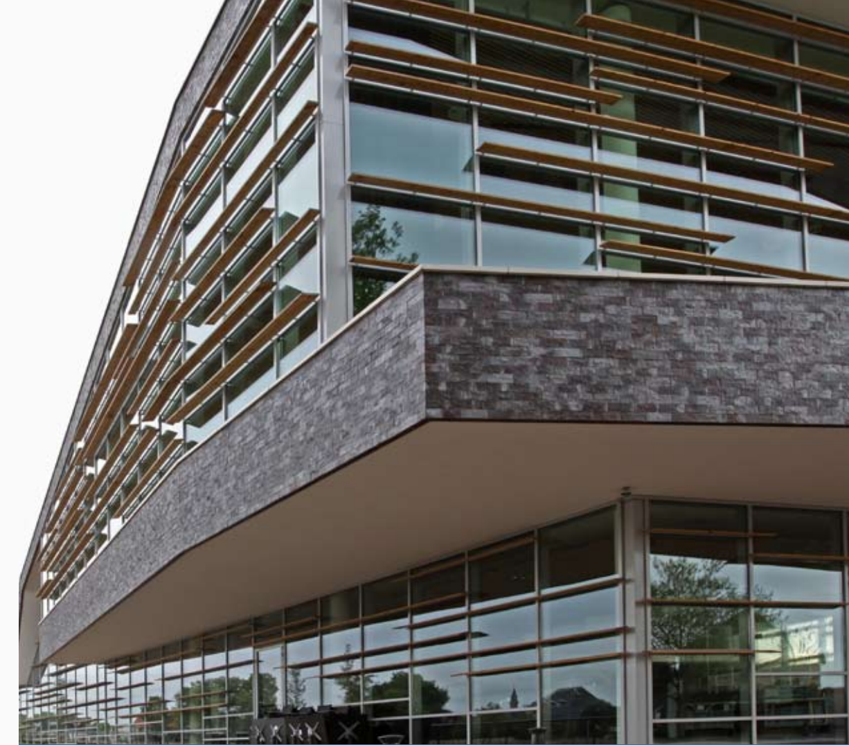
Karakteristiek element in de vliesgevels: de horizontale houten lamellen
